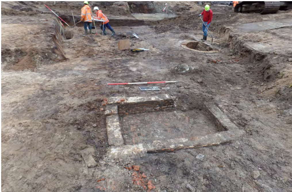
Afb. 5.20. Op de voorgrond de kelder van F1465 met op de achtergrond de beerput van F1464.
