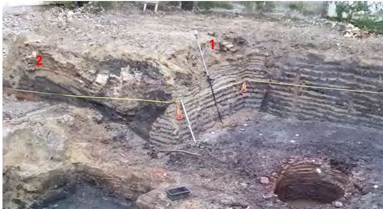
Afb. 5.16b. Overzicht zuidelijke deel van de put. In de afbeelding bij 1 restant van bakstenen funderings sleuf en bij 2 een restant van een verzakt bijgebouw.
