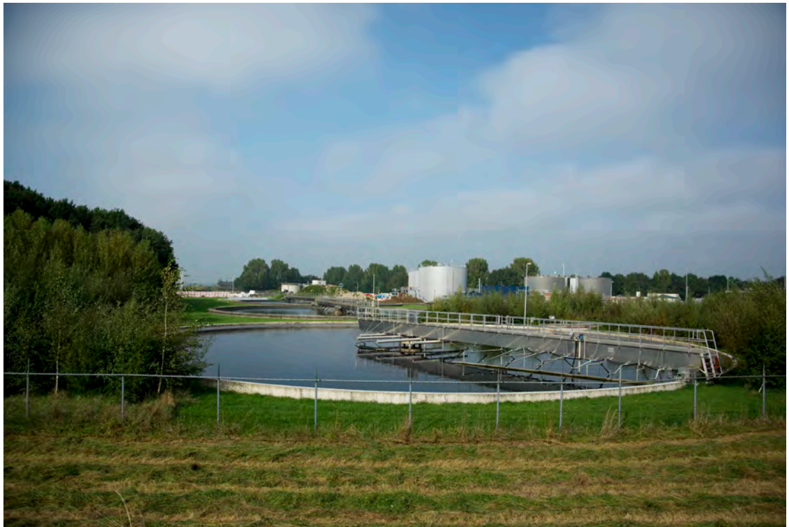
Afb. 4.4. Het huidige RWZI gebouw (J. Drost 2017).
