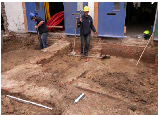
Afb.3.1. Het aanleggen van het eerste vlak (Archeologie Zwolle, 2014).
