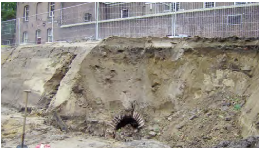
Afb. 9. Baksteenriool in bouwput van theater De Spiegel.
