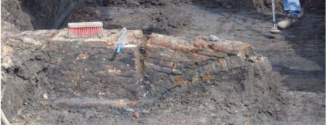
Afb. 43. Verzakking spaarbogen van het pakhuis.
