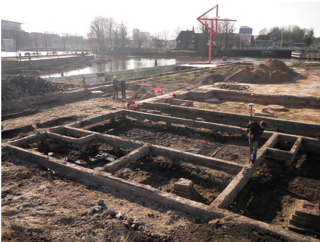
Afb. 57. Overzicht fundering beton.
