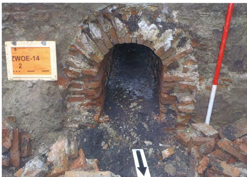
Afb. 11. Deel van noord-zuid riool onder de binnenplaats van het Spinhuis [Bron: ADC Archeoprojecten].
