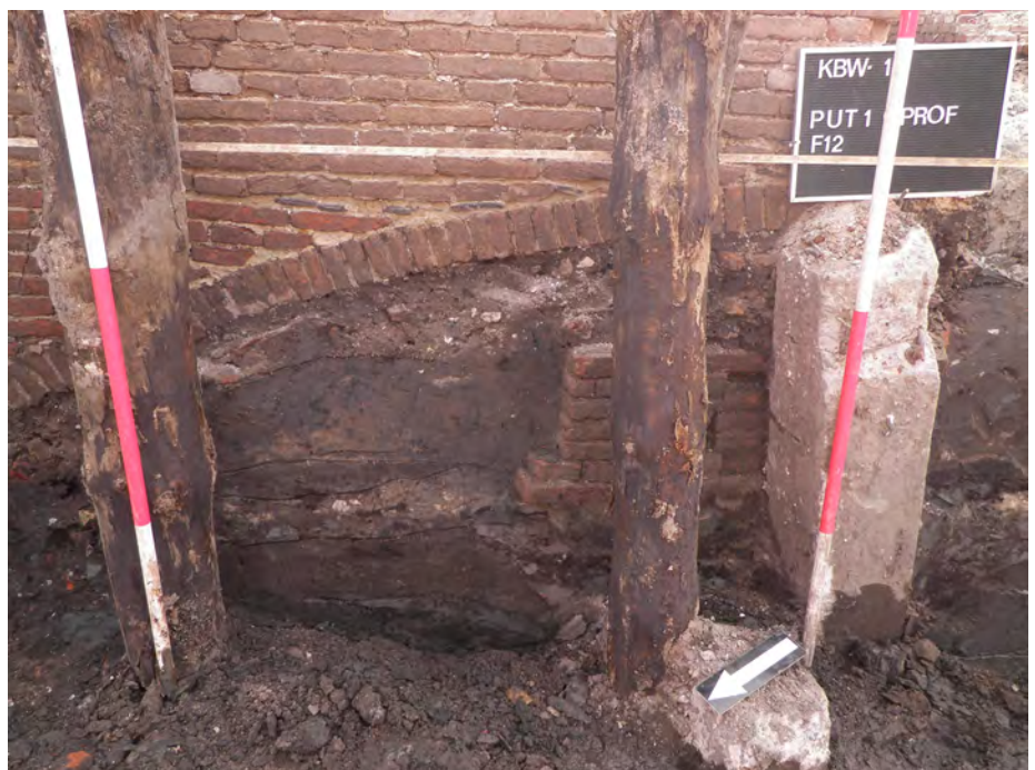
Afb. 44. Profielopname van de westzijde van het gebouw met daarin duidelijk zichtbaar de twee bouwfases.
