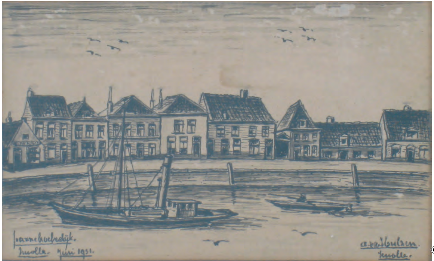
Tekening van A. van Hulzen uit juni 1951 van de Pannekoekendijk met daarop onder andere het cafe de Bollenhoek en het woonhuis van Wentholt met poortje naar de wasserij, coll. D.J. de Vries.
