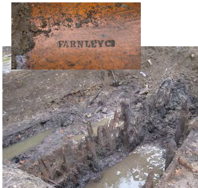
Beschoeiingsresten (S1377-1378, 1416-1417 en 1457) waartussen de grèsbuis heeft gelegen. Op deze grèsbuis was nog de naam Farnley Cs te lezen.
