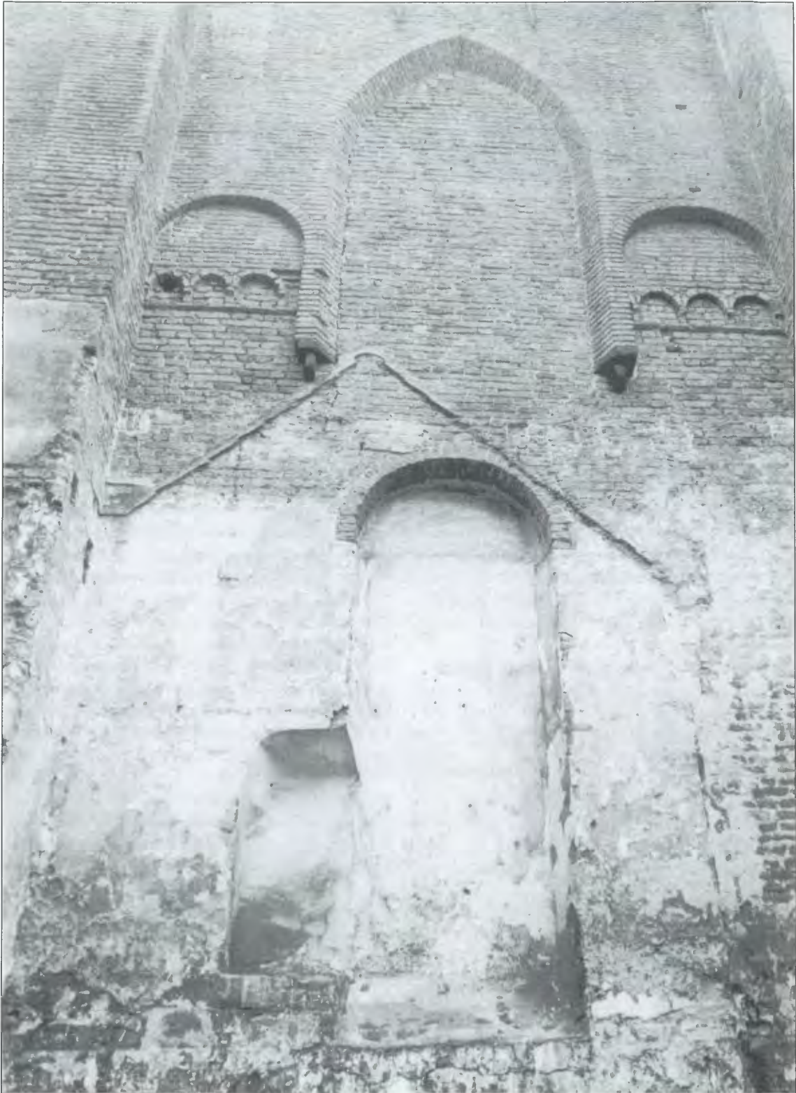
Afb. 7. Bouwsporen van de kapel van het Bethlehems klooster uit 1307-1308 in de huidige noordzijde van de Bethlehemkerk.
