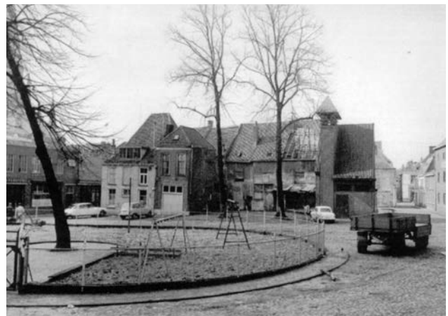
Huizen Achter de Broeren/ Vosjessteeg, rechts het Transformatorhuisje uit 1933.
