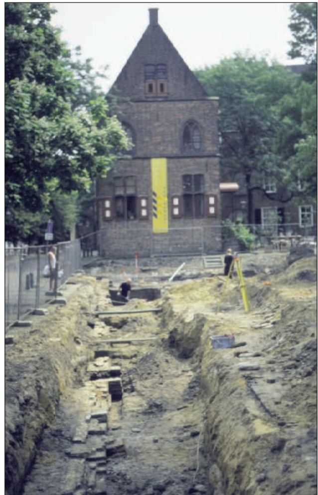
Omheiningsmuur westelijke hof.
