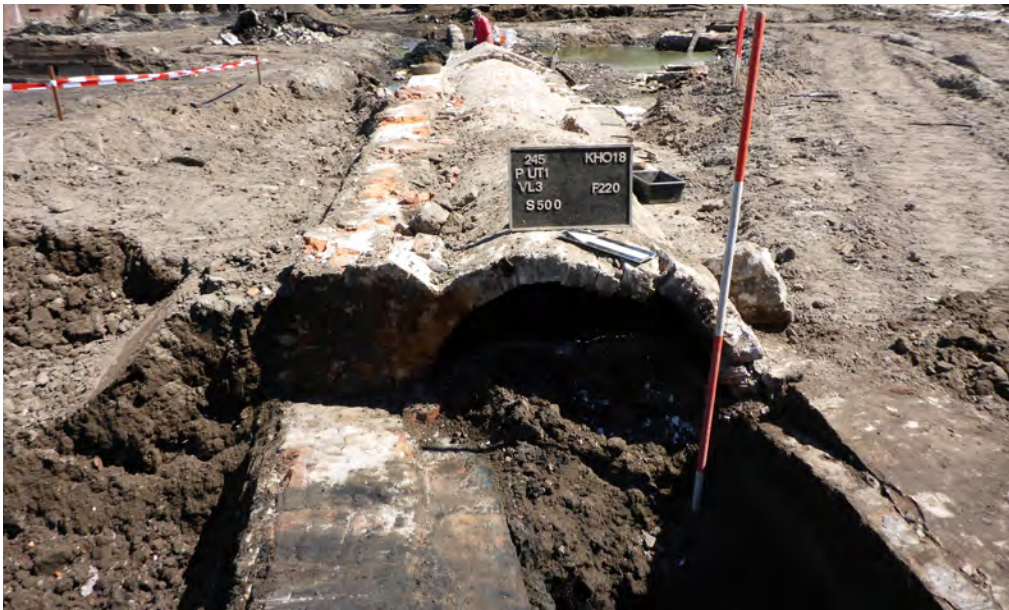
Figuur 35. De oudere, overkluisde watergang met een rond gewelf (S500).
