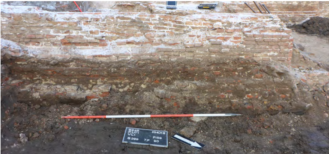
Figuur 84. Linkerzijgevel S77 bovenop de oudere funderingen (S90 en 299) van het naburige pand op perceel E329.
