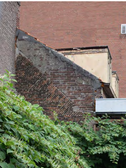
Figuur 119. Westelijke kopgevel met vlechtingen en latere verhoging.
