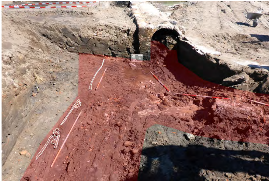
Figuur 21. Structuur 14 (wit) gaat rechtdoor richting het Zijltje terwijl het riool de bocht omgaat richting de Hoogstraat.
