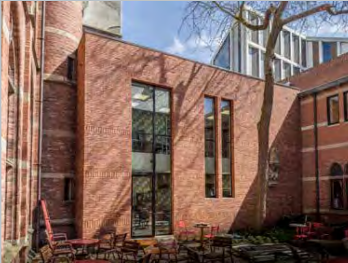
Nieuwe keukengebouw op de binnenplaats (Foto: Team Erfgoed Zwolle).
