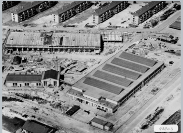
Een luchtfoto van het Philipsterrein uit 1955 met het ZB gebouw in aanbouw. Het ketelhuis en een gedeelte van het ZA gebouw zijn dan al klaar (Bron: KLM-Aerocarto).
