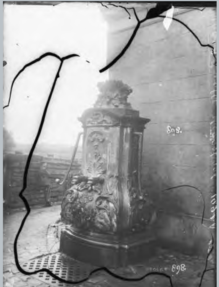
De pomp oorspronkelijk aan de hoogstraat nu te zien aan de Luttekestraat. Rijksdienst voor het Cultureel Erfgoed, Amersfoort / Documentnummer 20231389
