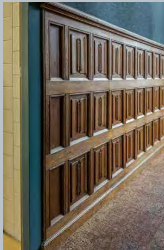
Herstelde lambrisering (Foto team Erfgoed).
