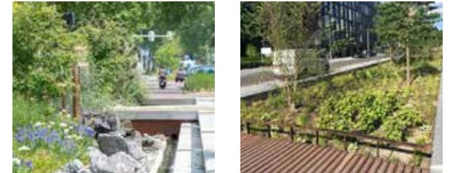
Beplante wadi's zorgen voor zichtbare bergings- en infiltratiecapaciteit
