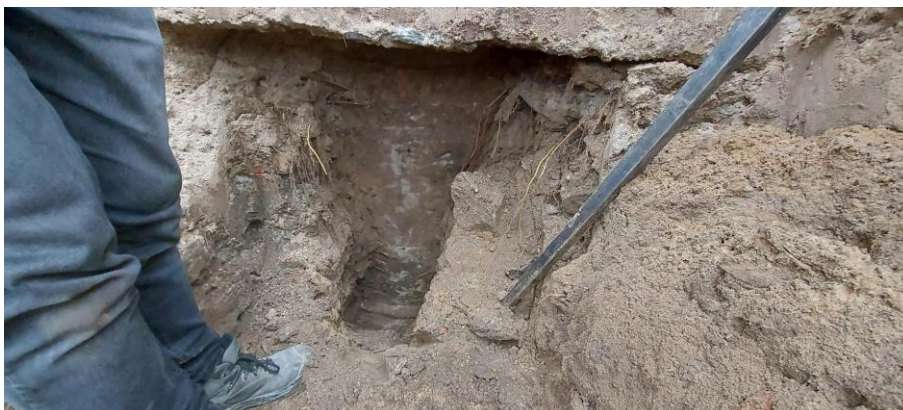
Foto 4; Foto's van inspectieput b.
