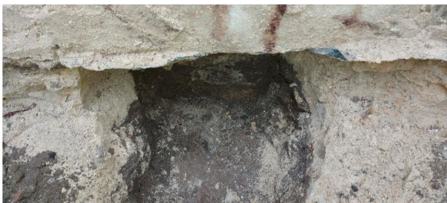
Foto 2; Foto's van inspectieput a.
