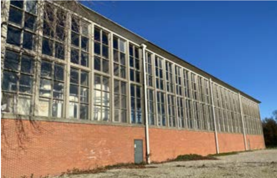
Afb. 49 De zuidelijke gevel van het koelwaterfiltergebouw met een bakstenen onderbouw en een transparante opbouw met glas in prefab betonframes.
