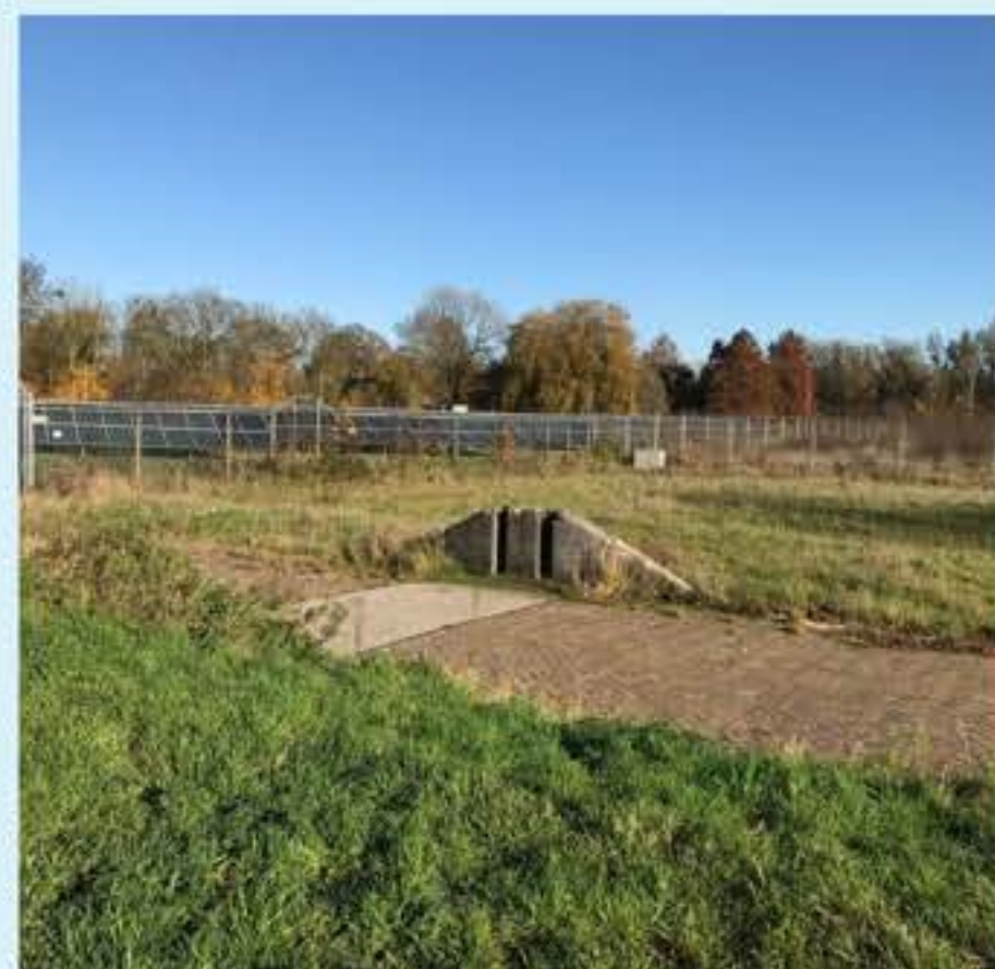
betonkering vm toegangsweg af te sluiten met schotbalken
