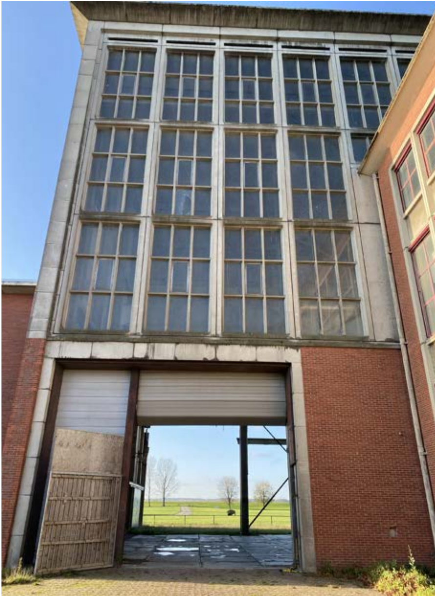
Afb. 69 Doorzicht naar het stelconpad en de Ijsseldijk.
