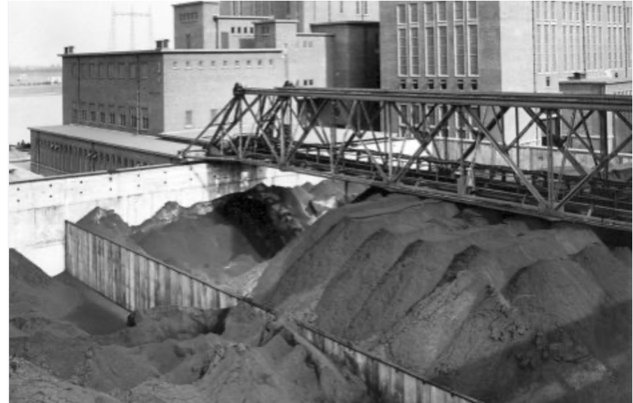
Afb. 21 Beeld van het kolenpark voor de kolenopslag bij de Gelderland Centrale II langs de Waalhaven bij Nijmegen (Bonas).
