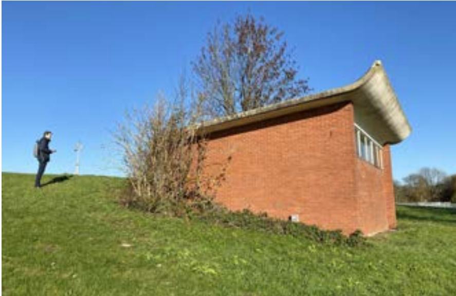
Afb. 55 Het vacuümgebouw tegen de dijk bij de noordelijke haven heeft een kenmerkende wederopbouwarchitectuur met een tot dak doorgetrokken betonnen achterwand.
