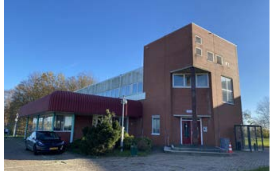
Afb. 52 Het entreegebouw met portiersloge en later aangepaste entreepartije.
