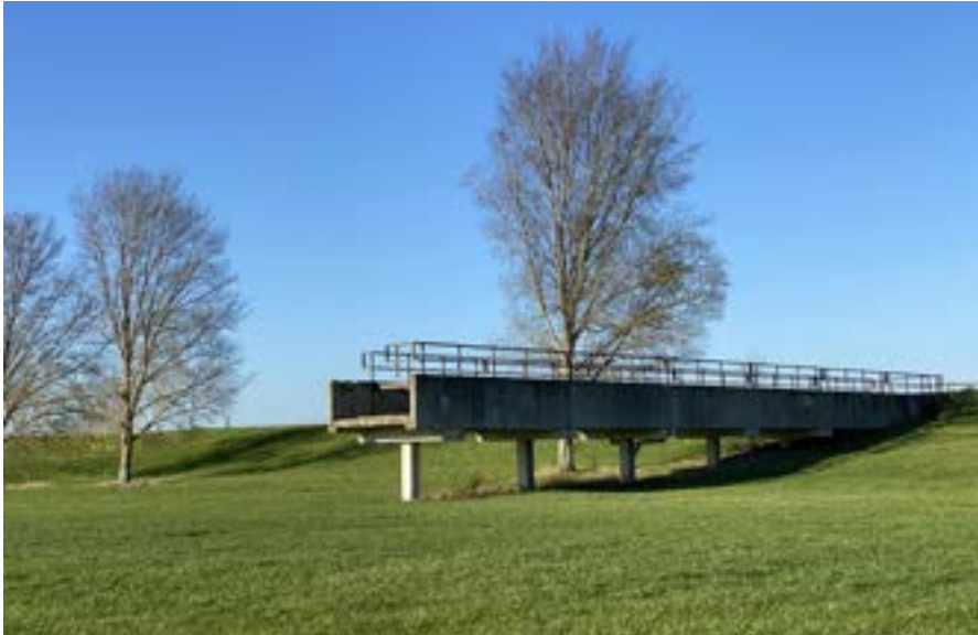
Afb. 23 Deel van de betonnen leidingbrug die van de oliesteiger naar het tankenpark liep.
