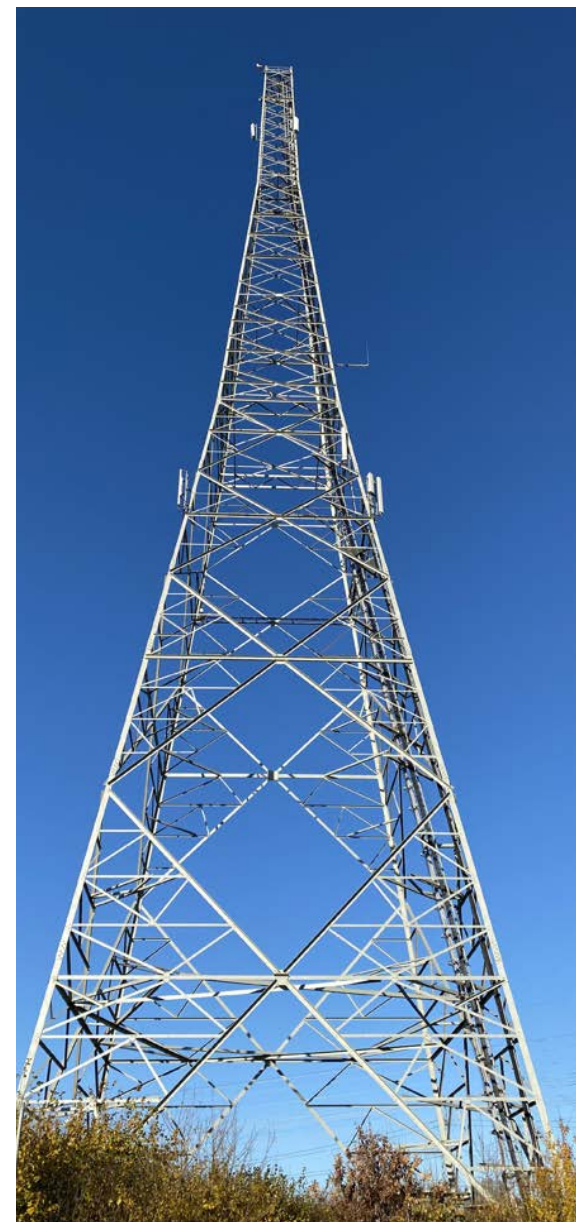
Afb. 30 De huidige blikvanger van het schakelstation en het terrein van de centrale.
