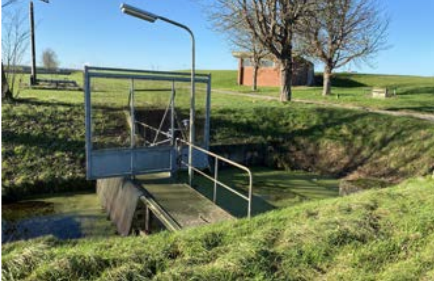
Afb. 25 Het gemaal over sluisje dat op de situatie van 1956 staat aangemerkt als 'noodgemaal'. Op de achtergrond een van de twee vacuümgebouwtjes.
