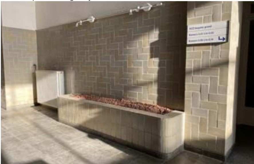
Afb. 44 De entreehal van het dienstengebouw.
