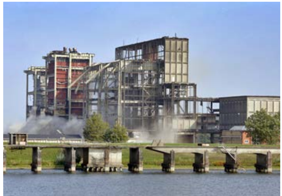
Ontmantelen van de IJsselcentrale
