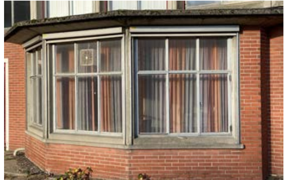
Afb. 45 Portiersuitbouw van het dienstengebouw.
