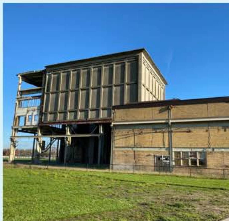
Restant machinekamer en magazijn
