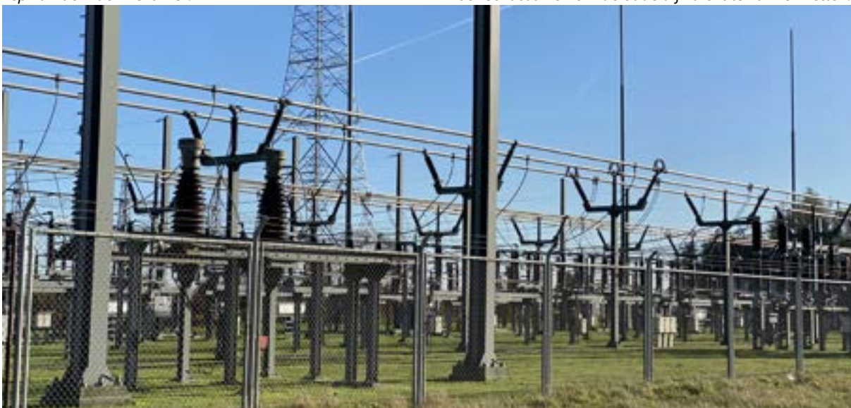
Afb. 29 Huidige aanzicht van het schakelstation op het voorterrein tussen het spoor en de kolk.
