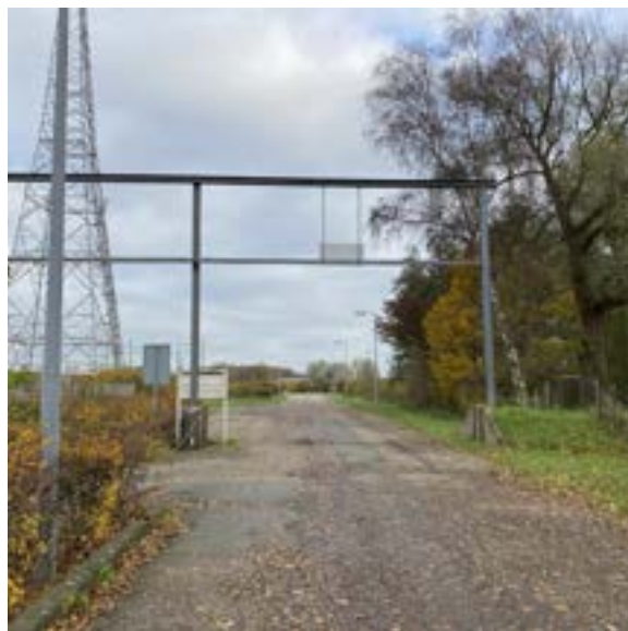
Afb. 28 De nieuwe toegangsweg met betonnen wanden voor schutbalken om de oude dijk dicht te kunnen zetten.
