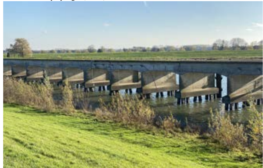
Afb. 20 Restant van de kolensteiger in de zuidelijke haven met een vergelijkbare constructie als de basis van de kolentip, zie de afbeelding hiernaast.
