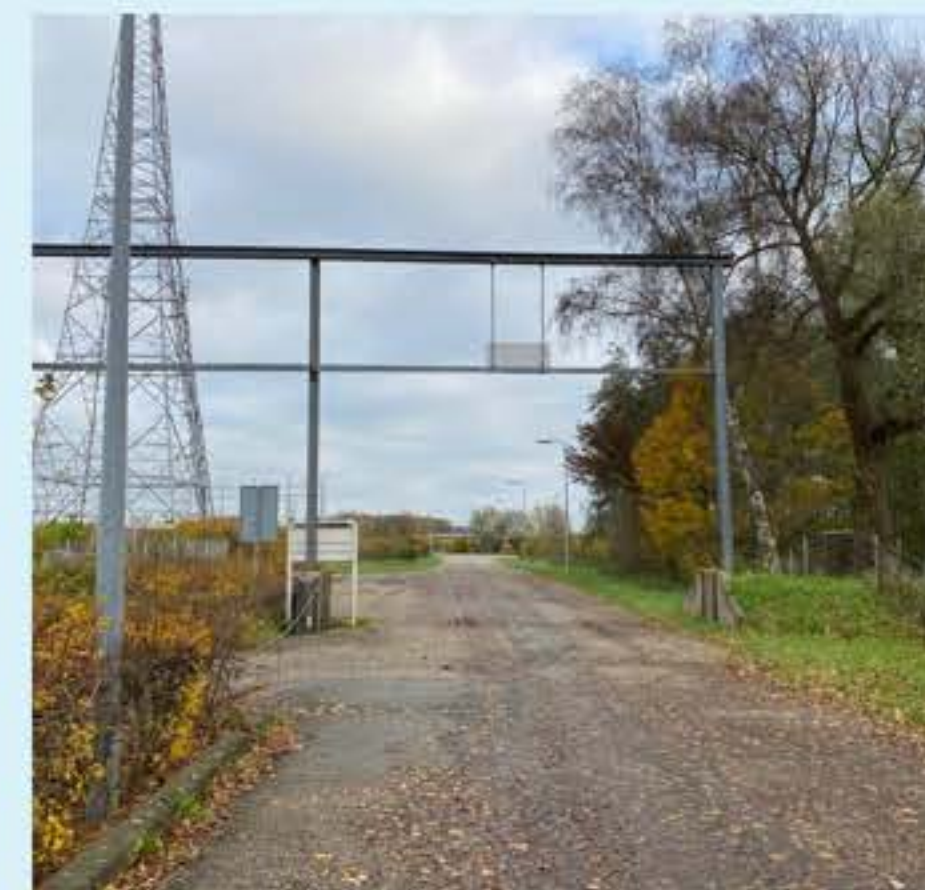
Betonkering huidige toegangsweg
