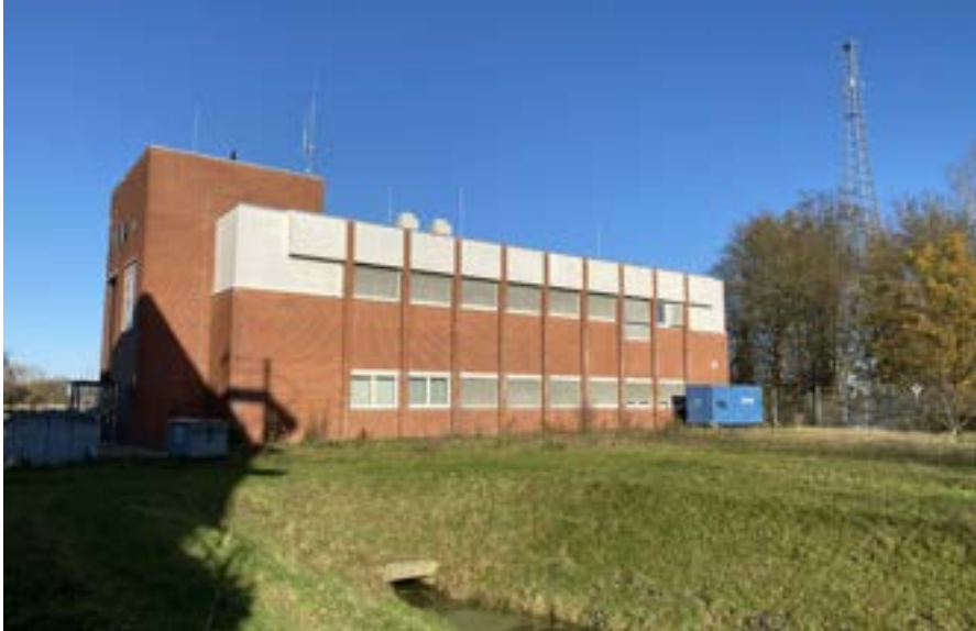
Afb. 53 De achterzijde van het huidige entreegebouw.
