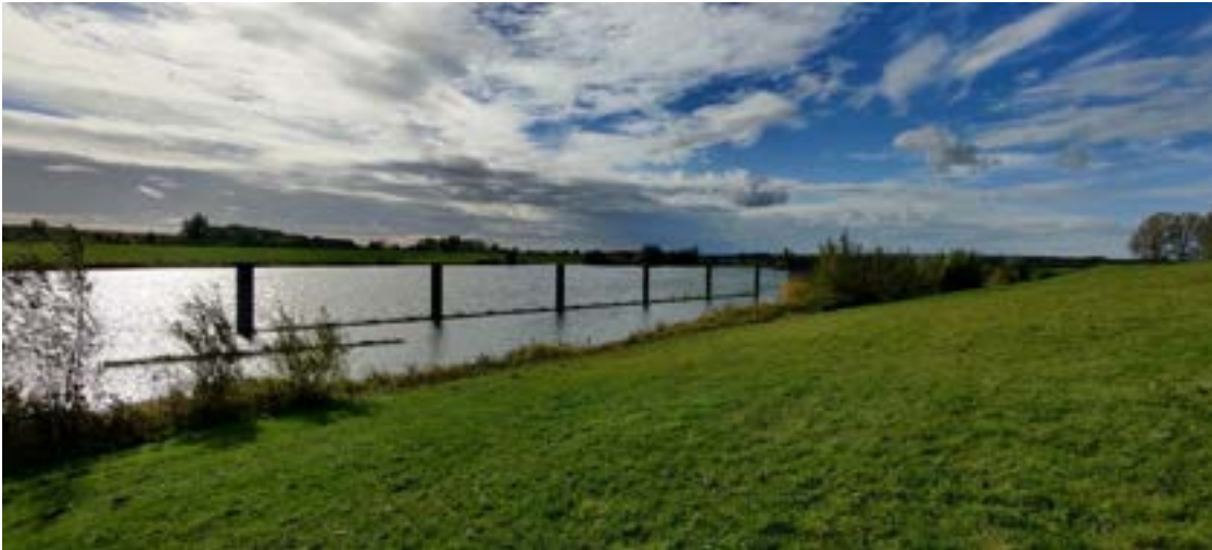
Figuur 3-7: Zuidelijke insteekhaven, onderdeel van Natura 2000-gebied Rijntakken, en de aangelegde dijk (foto RHDHV).
