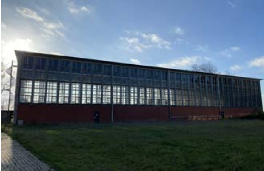
Afb. 51 Het transparante koelwaterfiltergebouw gezien vanuit het noorden. Het gebouw is enkele keren uitgebreid.
