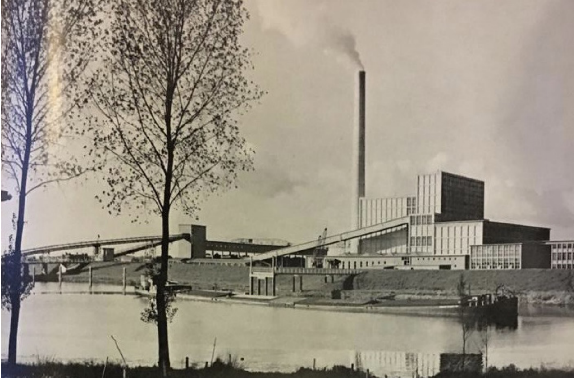
Afb. 18 Aanzicht van het complex net na de bouw nog met twee units en een schoorsteen, met rechts vooraan het zuiveringsgebouw. De foto is genomen van de oostelijke dijk van de inlaat- of kolenhaven (Bouwkundig Weekblad 1956).
