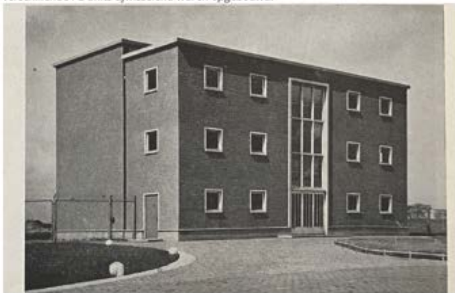
Afb. 37 Het al enige tijd geleden afgebroken Regionaal Centrum dat langs watergang parallel aan de IJsselcentraleweg stond, 1956 (Bouwkundig Weekblad).
