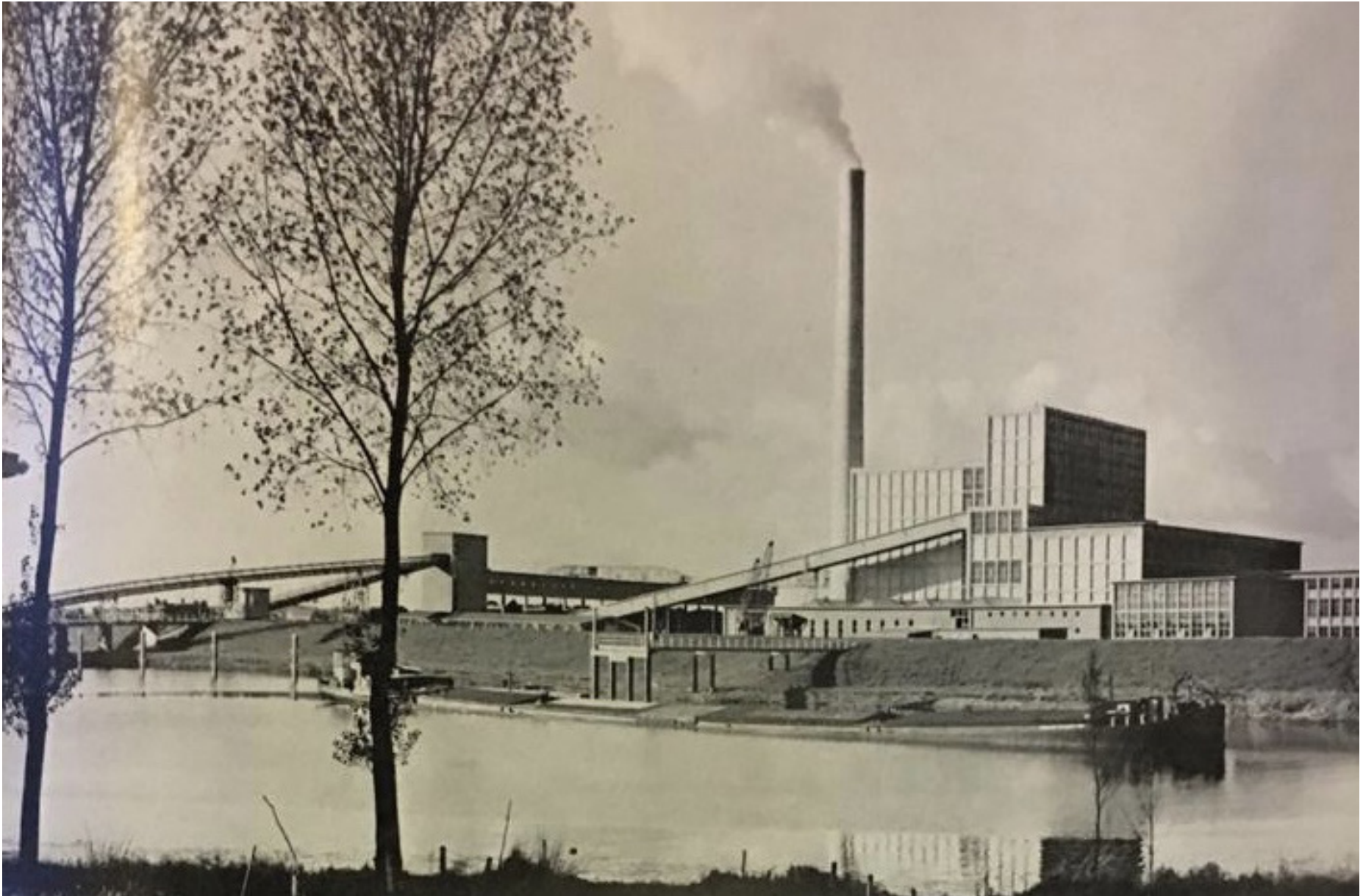
Afb. 18 Aanzicht van het complex net na de bouw nog met twee units en een schoorsteen, met rechts vooraan het zuiveringsgebouw. De foto is genomen van de oostelijke dijk van de inlaat- of kolenhaven (Bouwkundig Weekblad 1956).
