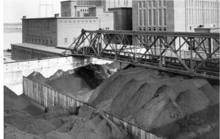
Afb. 21 Beeld van het kolenpark voor de kolenopslag bij de Gelderland Centrale II langs de Waalhaven bij Nijmegen (Bonas).
