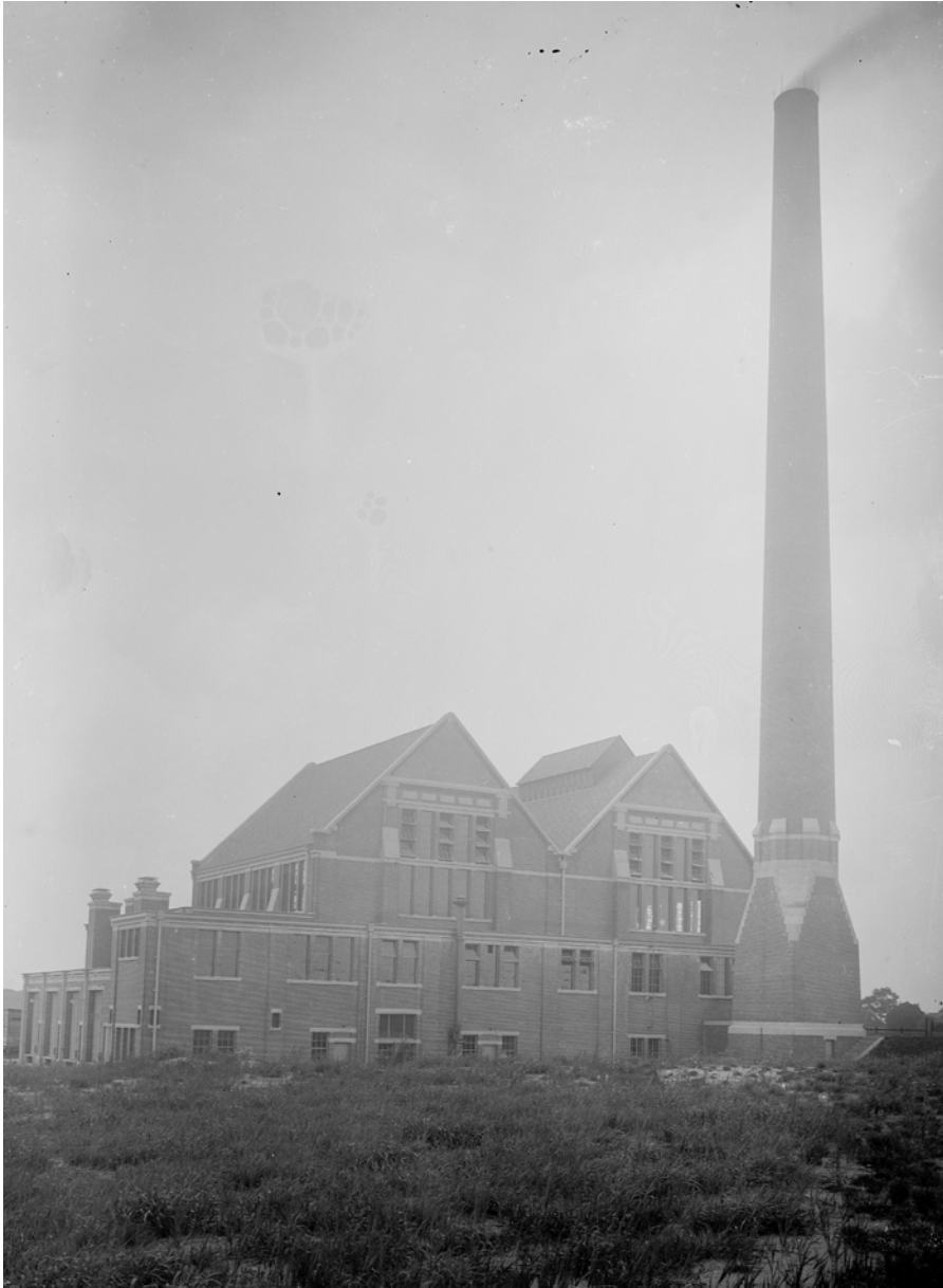
Afb. 17 De eerste IJsselcentrale aan de Wetering in Zwolle uit 1915.
