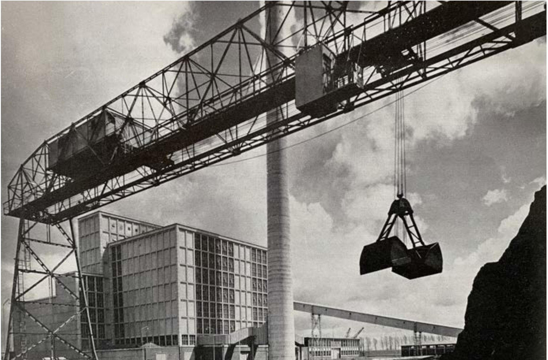
Afb. 14 Zicht op de westgevel in 1956 (Bouwkundig Weekblad).
