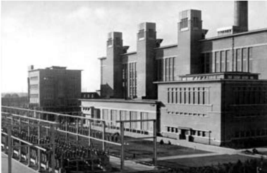
Afb. 34 Centrale Gelderland II Waalhaven Nijmegen (Bonas).
