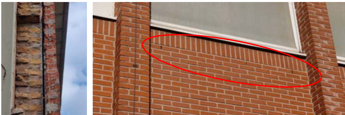
Figuur 5-11: Open spouwmuur in het magazijn (links) en open stootvoegen in de portiersloge annex kantoorgebouw (rechts), geschikt als verblijfplaats voor vleermuizen (foto's: RHDHV).
