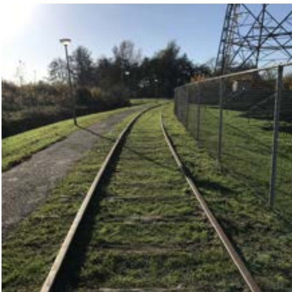
Afb. 27 Restant van het werkspoor dat naar de hijshal liep van de machinekamer.
