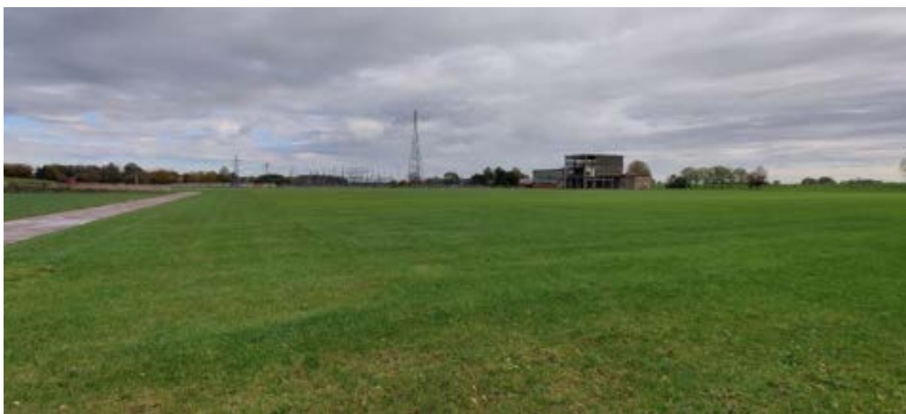
Figuur 3-6: Open grasland, waar de voormalige Centrale Harculo stond, met zicht op de nog aanwezige gebouwen (foto RHDHV).
