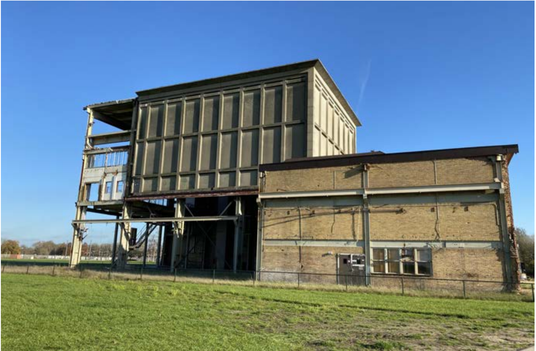
Afb. 42 Resterend deel van de hijshal van de machinehal (links) en de westgevel van het magazijn, waarin de binnenwanden en de binnenschil van het casco waren opgetrokken uit gele bakstenen terwijl de buitenwanden in rood metselwerk zijn opgetrokken.
