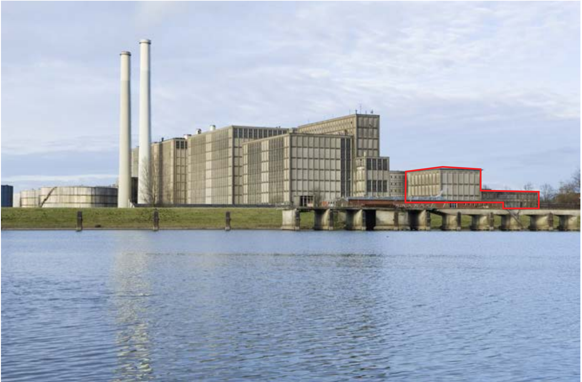
Afb. 41 De IJsselcentrale enige jaren voor de sloop (RCE 527030) met nog maar twee schoorstenen. Van deze foto staan alleen de gebouwen achter de kolensteiger en het magazijn, de werkplaats en het dienstengebouw, er nog (rood omrand).
