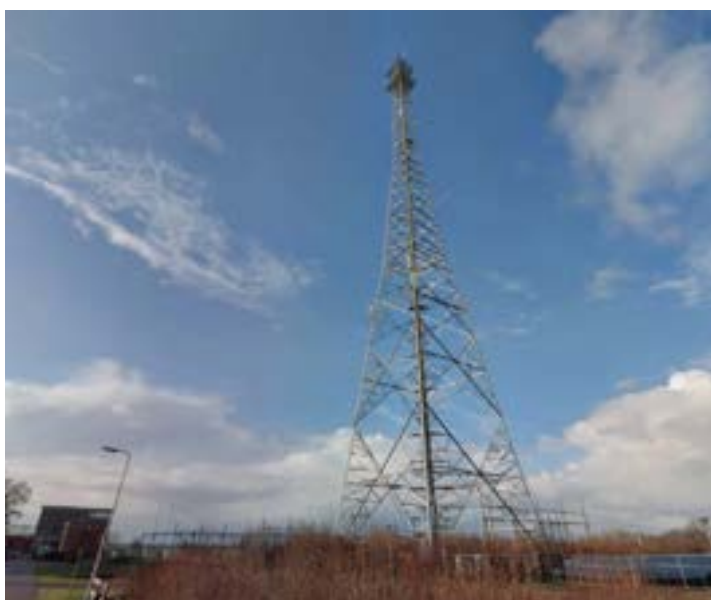
Figuur 5-13: Communicatiemast waarin de slechtvalkkast zich bevindt (Cyclomedia, 2020).
