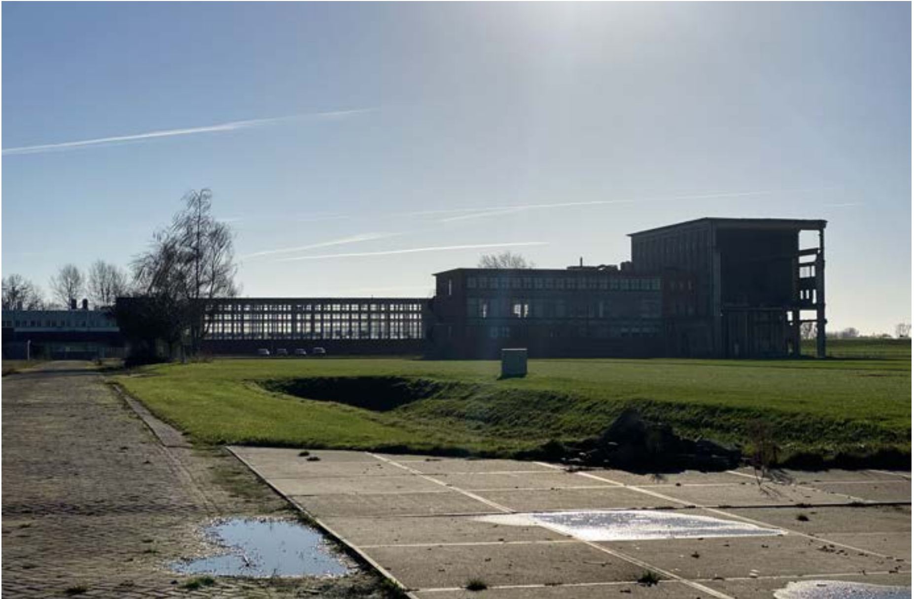
Afb. 1 Aanzicht van het grootste deel van de resterende gebouwen van de centrale Harculo gezien naar het zuiden vanaf de IJsselcentraleweg richting koelwaterfiltergebouw en het dienstengebouw.
