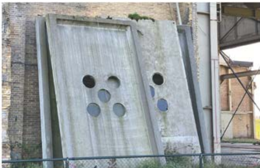
Afb. 35 Een van de twee decoratieve elementen op de prefab betonplaten waarmee de verschillende PE units afwisselend waren opgebouwd.
