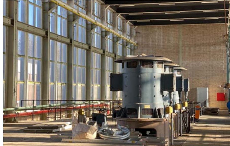
Afb. 50 Het interieur van oostelijke deel van het koelwaterfiltergebouw.
