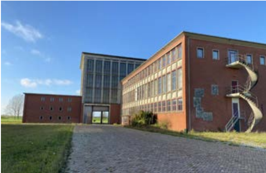
Afb. 46 Zicht langs het dienstengebouw (recht) onder de montagehal met de aangrenzende werkplaats richting de dijk.
