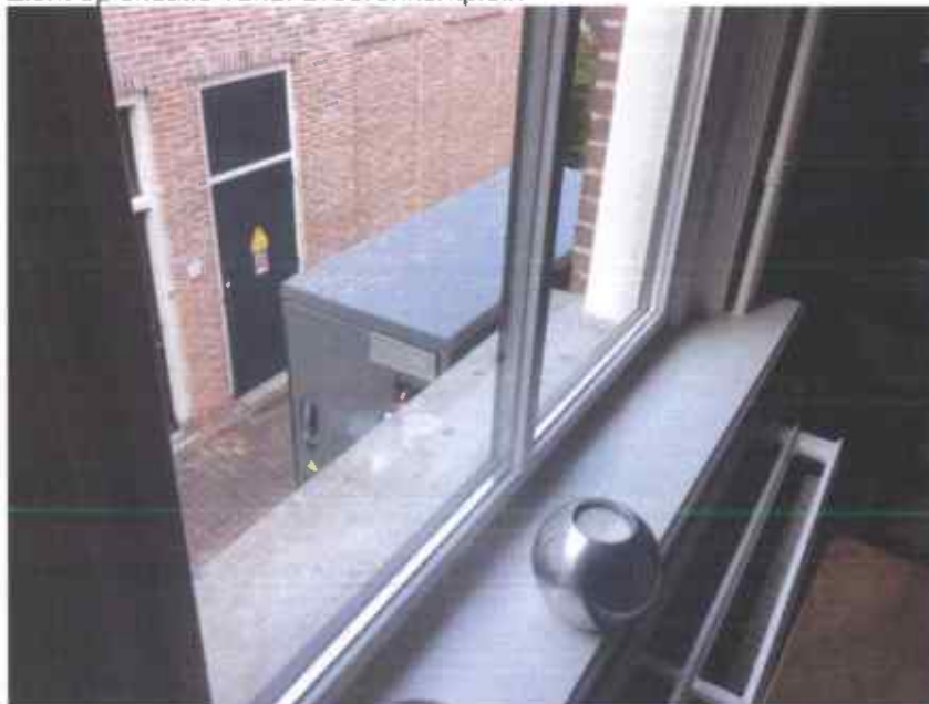
Zicht op installatie vanuit de woning Broerenkerkplein 5
