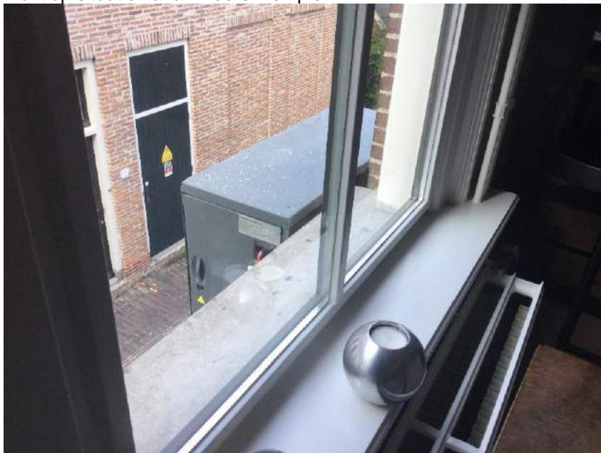
Zicht op installatie vanuit de woning Broerenkerkplein 5
