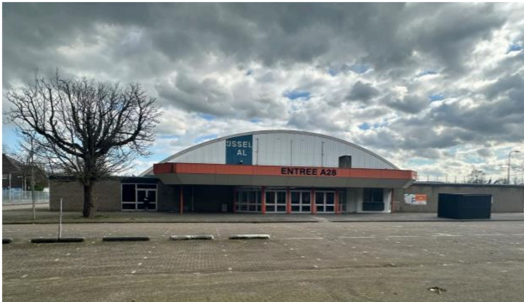
Bestaande entree en kopgevel
